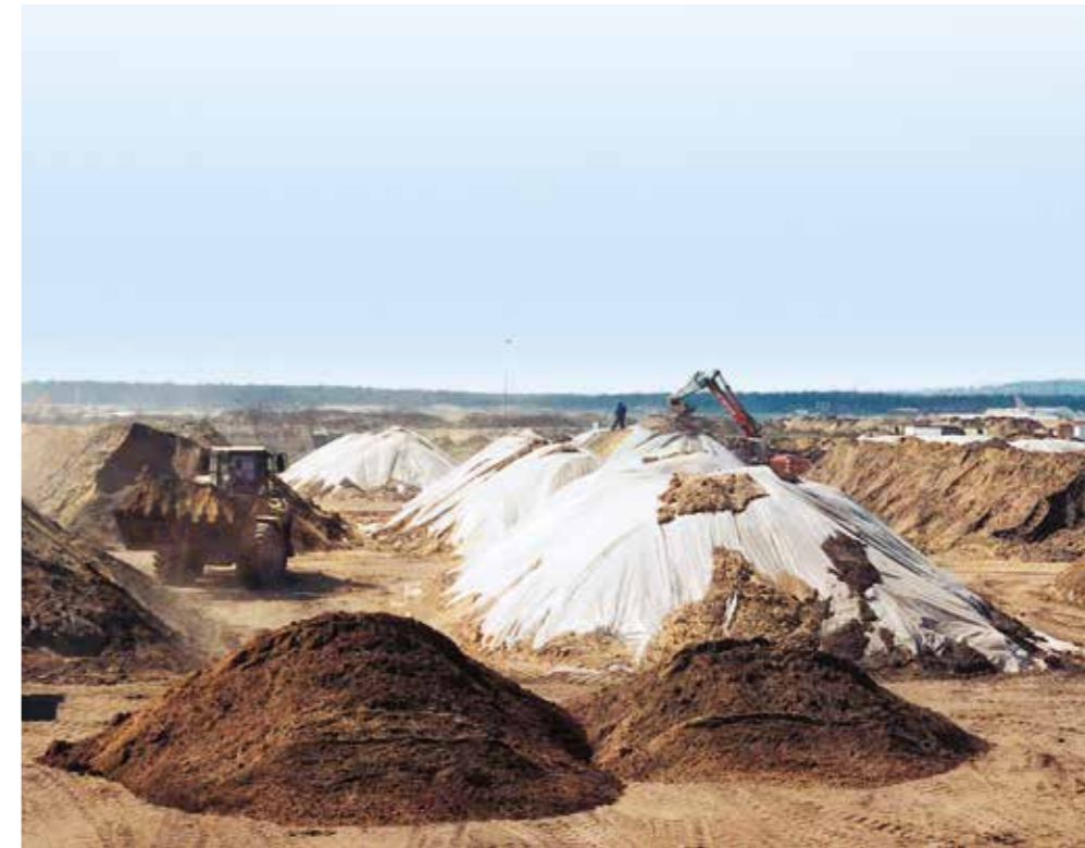
Boden- und Grundwassersanierung in Frankfurt
